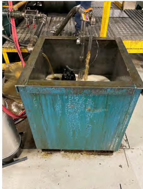
Muestra una mezcla inadecuada y evaporación
